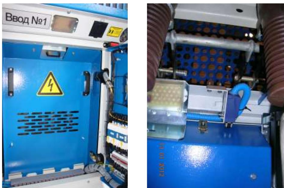
*Рисунок 1.1 Защитная перегородка (слева – вид снаружи, справа – вид изнутри камеры)*
