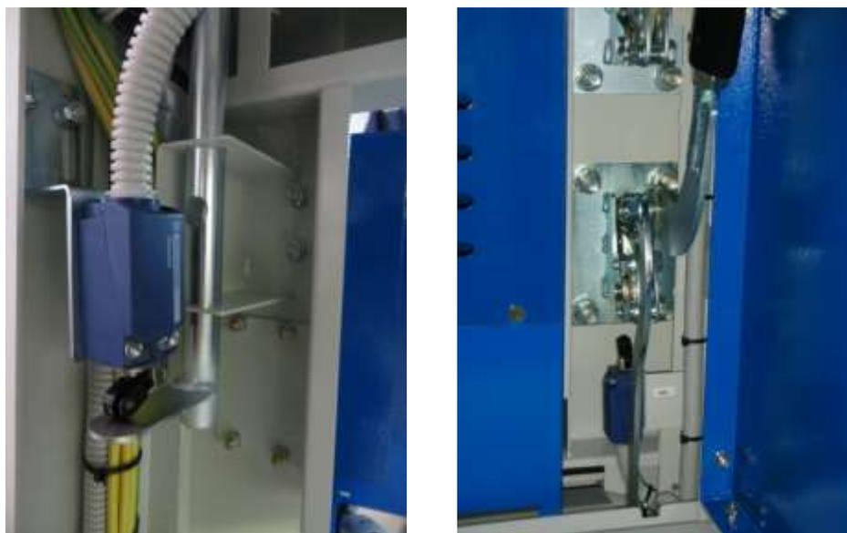
*Рисунок 1.12 Концевые выключатели положения ножей разъединителей*
