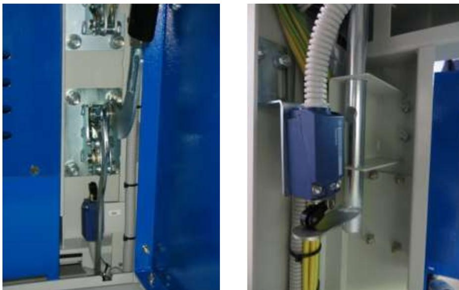
*Рисунок 1.18 Концевой выключатель главных ножей разъединителей (слева – шинного, справа – линейного)*
