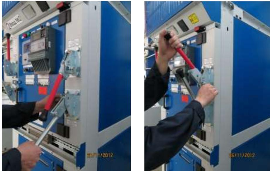
*Рисунок 1.13 Взаимная блокировка приводов (слева – «а»; справа – «б»)*
