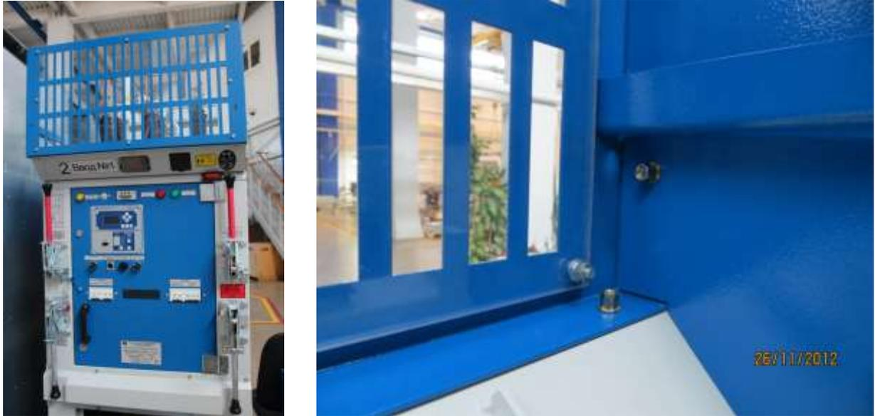
*Рисунок 1.3 Защитный экран сборных шин*
