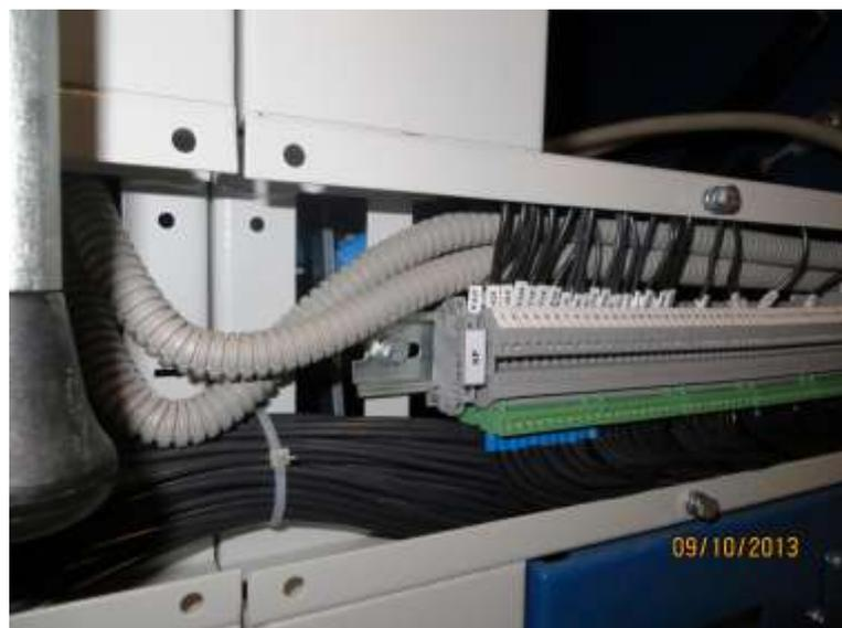
*Рисунок 1.10 Короб для межкамерных соединений*
