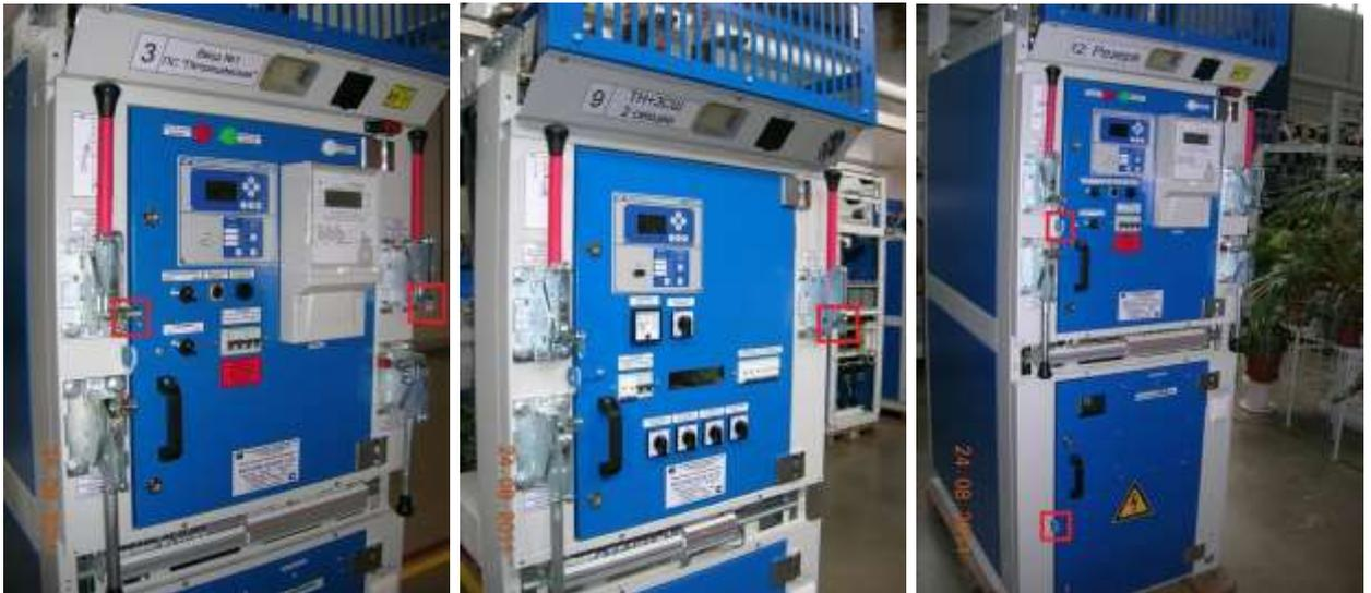
*Рисунок 1.15 Навесные замки (слева–1 тип, в центре–2 тип, справа–3 тип)*
