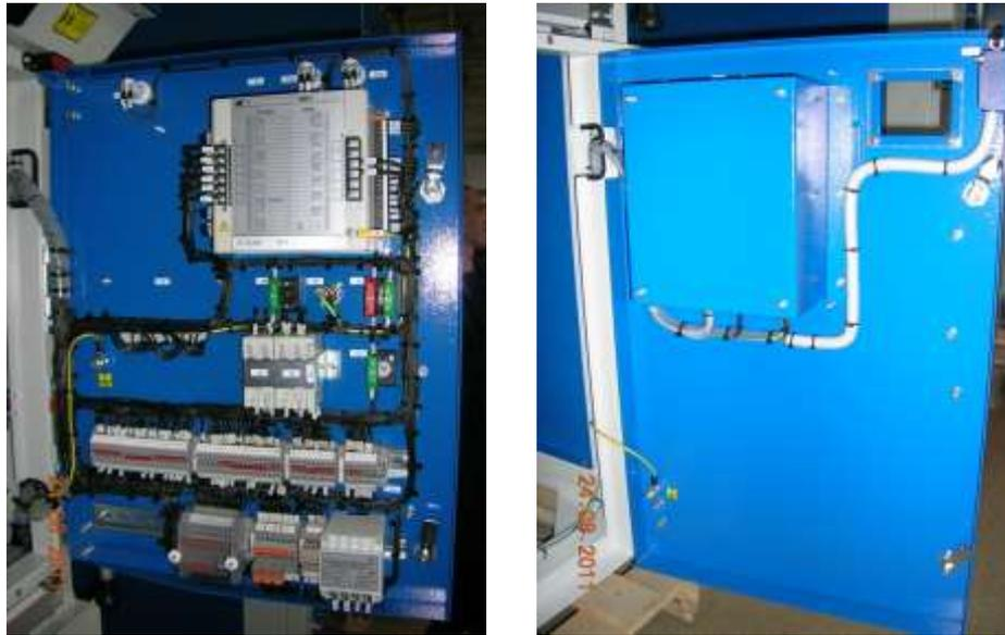
*Рисунок 1.4 Заземление дверей камер КСО (слева – верхняя, справа – нижняя)*
