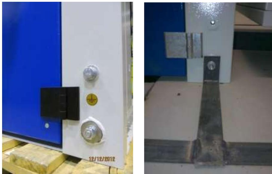
*Рисунок 1.5 Заземление (сверху – временный зажим, снизу – общий контур)*
