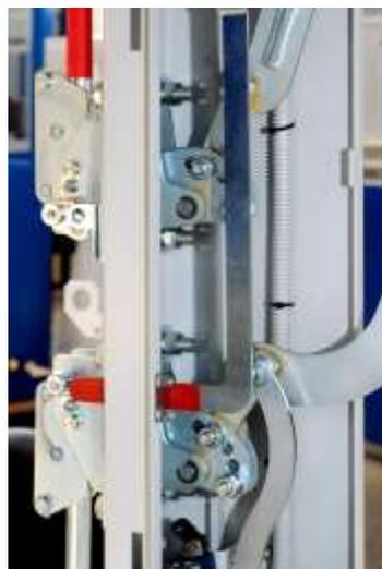
*Рисунок 1.16 Механическая блокировка с вакуумным выключателем*
